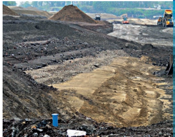
Bau eines Stadtsees: Grundwassermonitoring als wichtiges Element der Bauphase.
