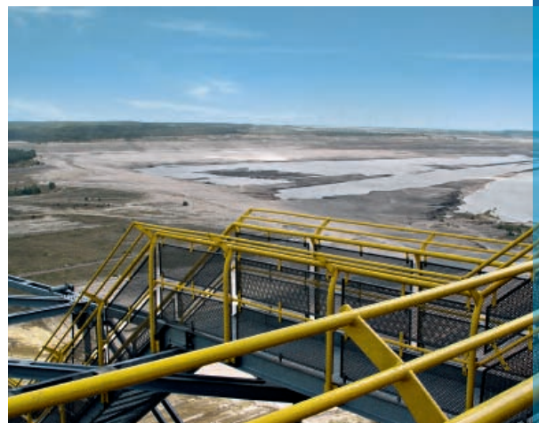
Braunkohletagebau in Südosteuropa: Großräumige Grundwasserhaltung.
