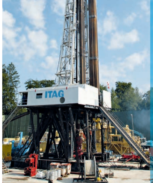
Erkundungsmaßnahme: Bohrgerät beim Abteufen einer Geothermie-Tiefenbohrung.
