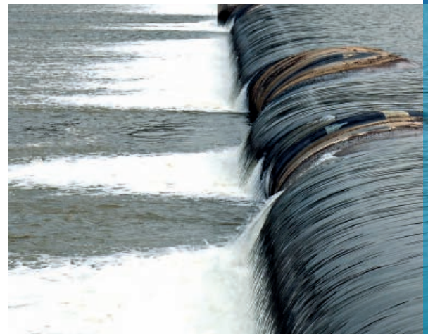
Wehranlage zur Regulierung des Flusswasserspiegels: Einfluss auf den Uferfiltratanteil einer Wassergewinnung.
