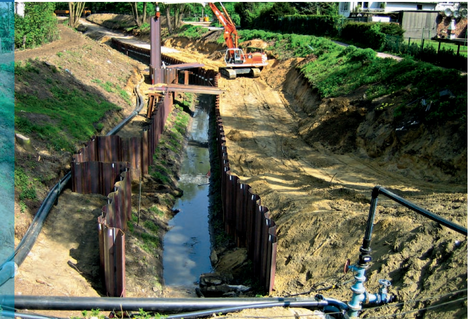
Nachhaltige Baumaßnahme: Wirksame Grundwasserhaltung durch Spundwände an einem Gewässer.
