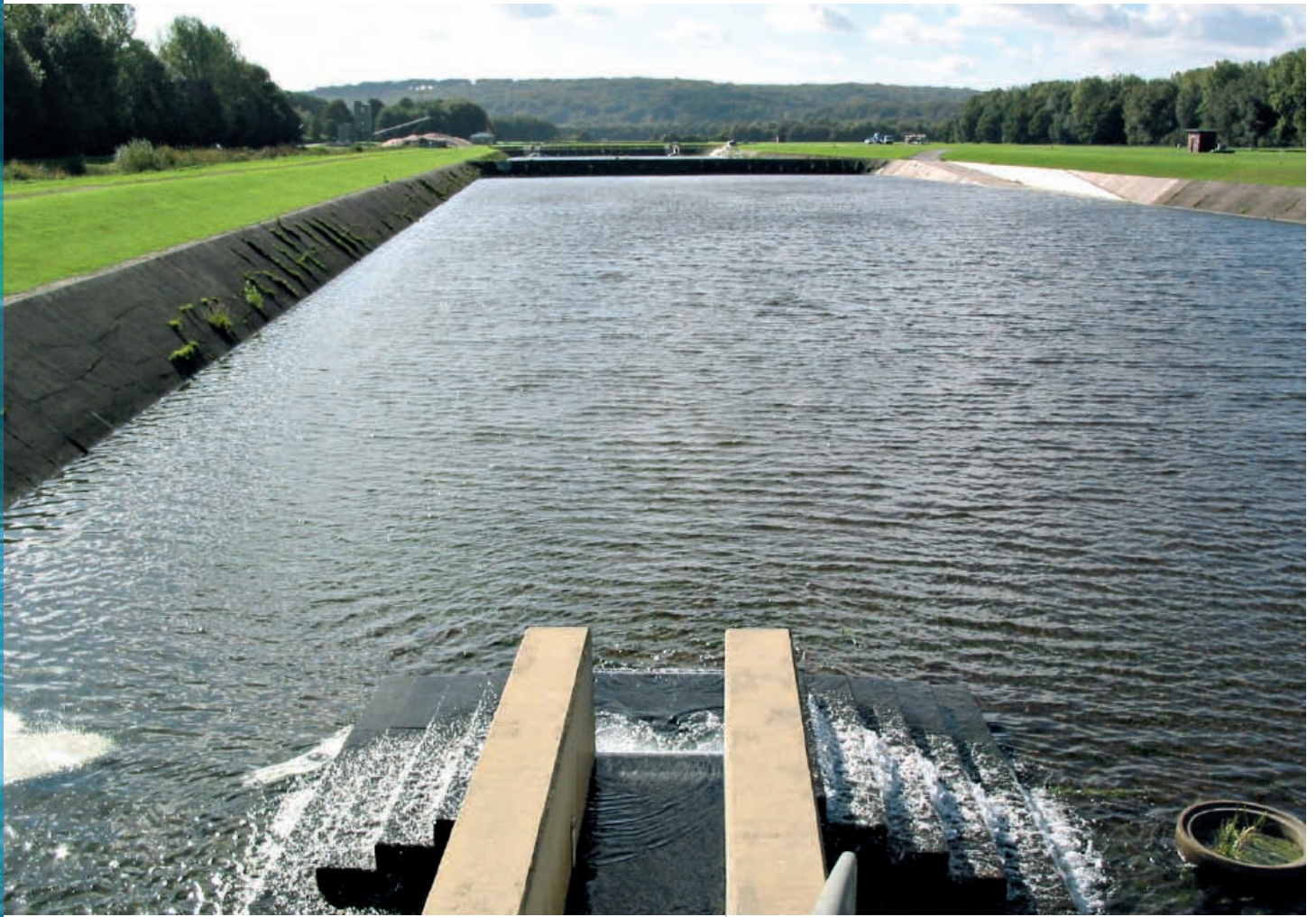
Versickerungsbecken: Grundwasseranreicherung durch Versickerung von Uferfiltrat.
